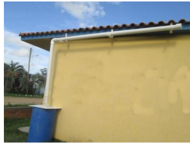
Figura 2: Calha para captação da água da chuva
